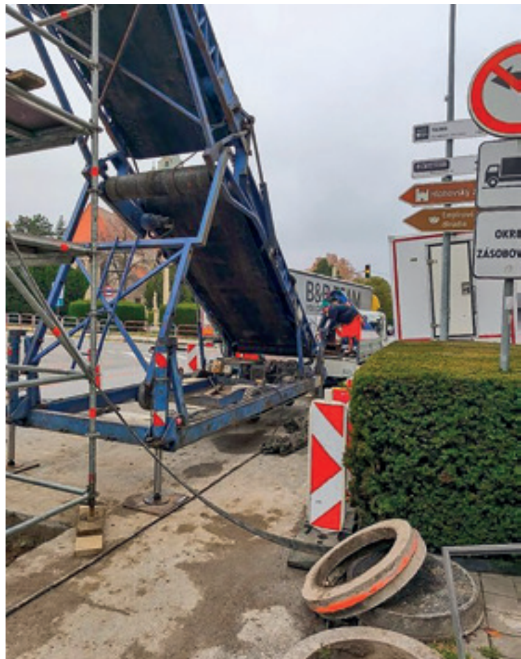
Inverzná veža – 2.etapa opravy metódou CIPP
