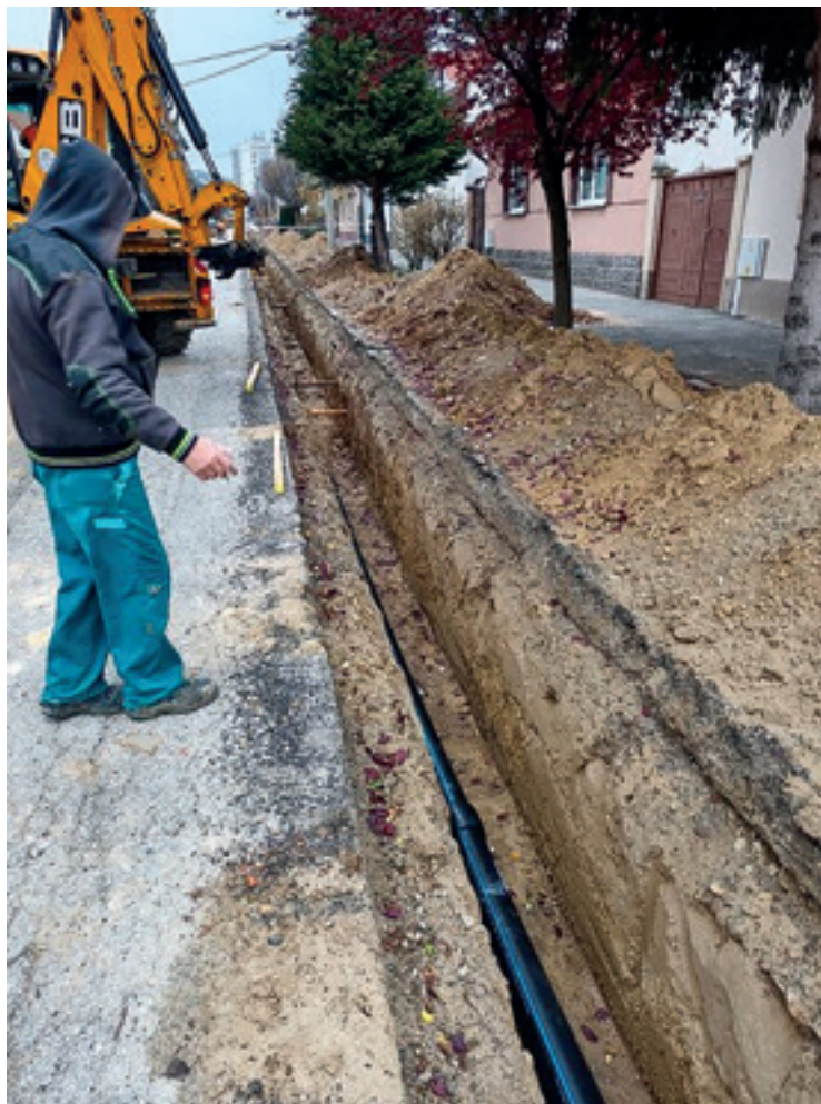
Rekonštrukcia verejného vodovodu - ul. Bernolákova
