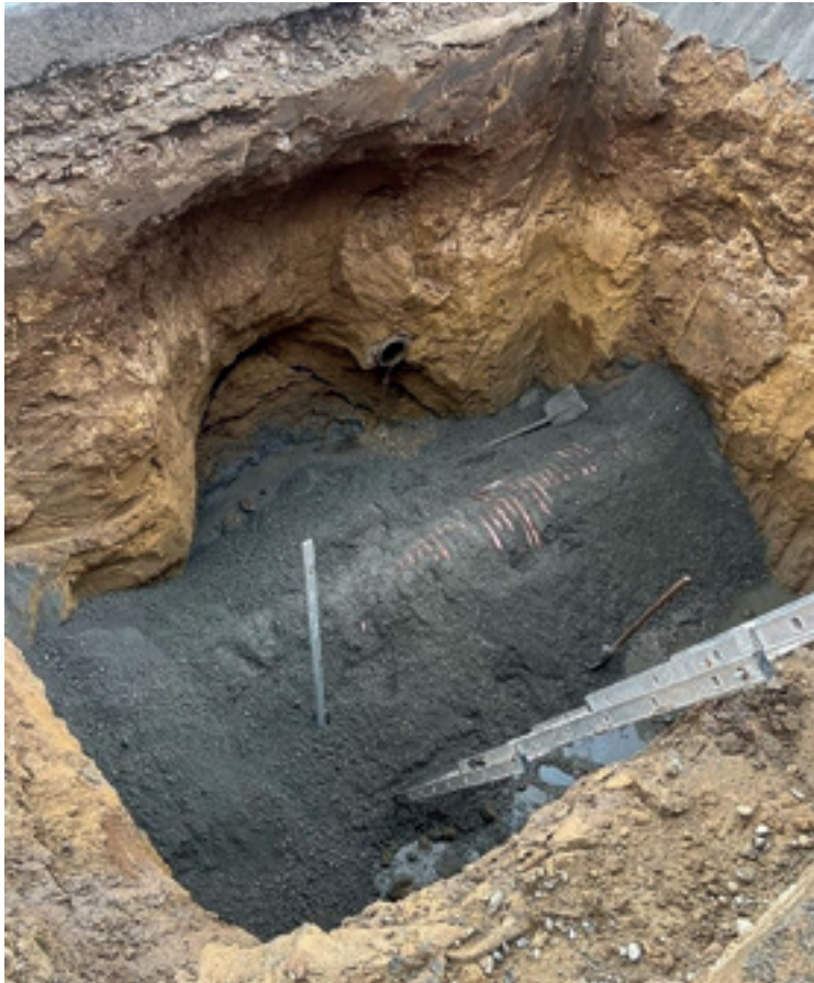
Bodová oprava verejnej kanalizácie na ul. Slov. národného povstania
