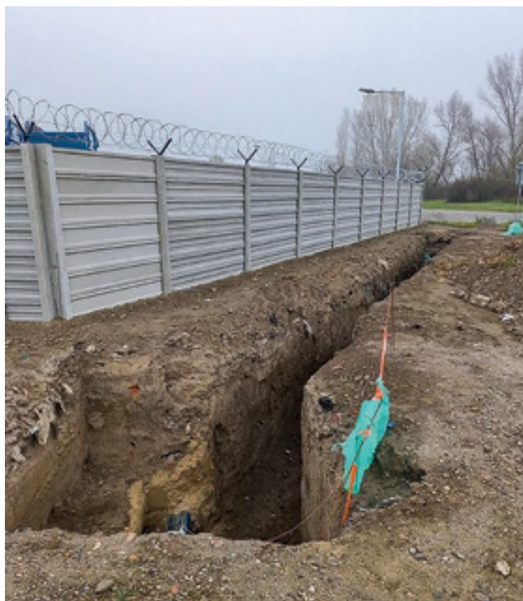
Prekládka verejného vodovodu - Zberný dvor
