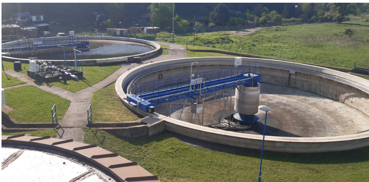
Rekonštrukcia dosadzovacích nádrží (DN 2- na obr. vzadu)
