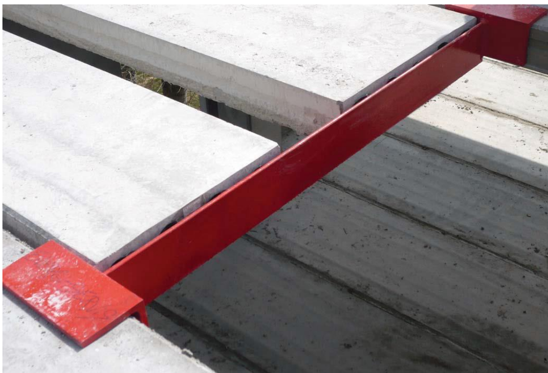
Oceľová výmena pre osadenie panelov
